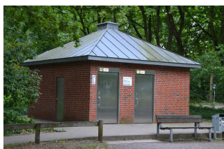
Öffentliches WC im Scheunenviertel
